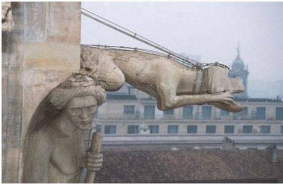
Sistema de descarga eléctrica en la catedral de Milano
